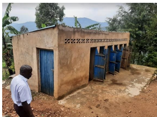
Latrines de l'école primaire Secteur Rusasa – cellule Kamonyi
