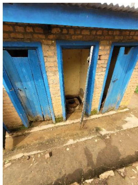
Latrines de l'école – Secteur de Rusasa – Cellule de « Mirambi »
