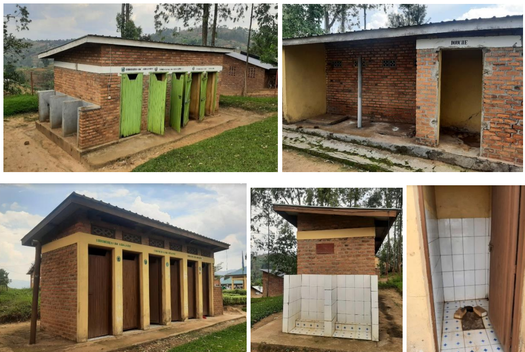
Latrines du centre de santé de la cellule de Nuhando
