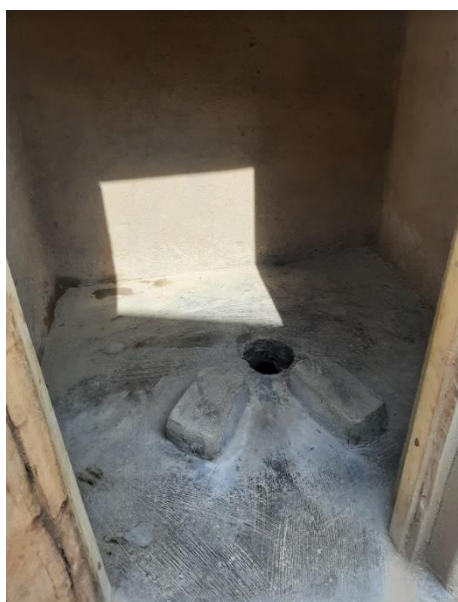
Dalle en ciment d'une latrine familiale construite dans le cadre du projet USAFI UP de HI.
