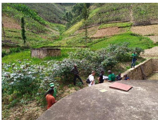
Station de pompage Munyana – Chambre de captage
