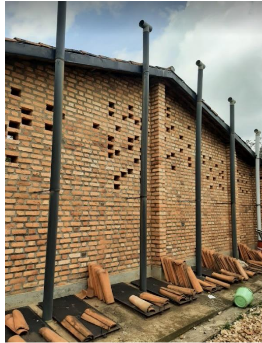
Vue arrière des latrines à double fosse avec trappes d'accès et ventilation.
