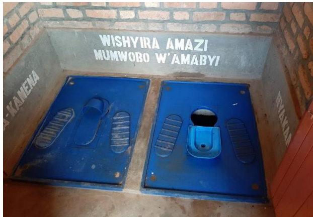
Système EcoSan à double fosse : utilisation alternée des fosses tous les 6 mois pour que le traitement de la matière se fasse à l'intérieur de celle-ci. Séparation de liquides et matières fécales. (Fosse gauche fermée et droite ouverte – accessible à l'utilisation)
