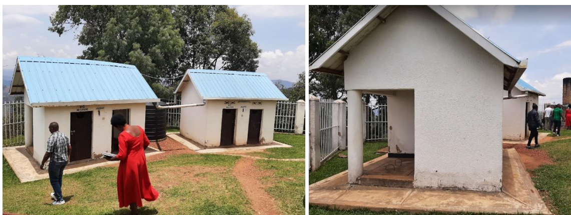
Latrines du centre de santé – Secteur de Minazi (photo de droite : dalle d'accès à la fosse)
