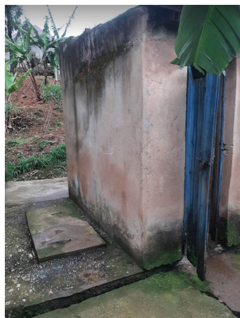
Dalle d'accès à la fosse
