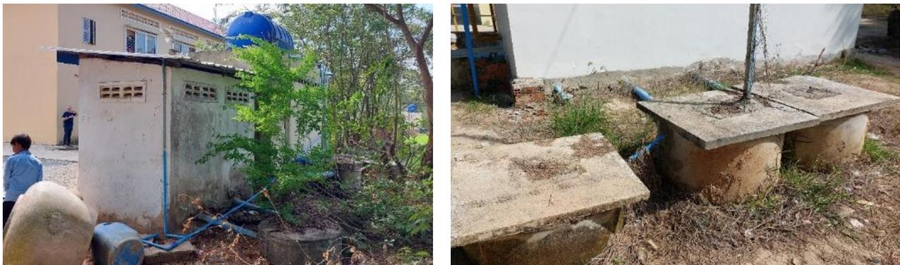
Figure 37 : Evacuations vers les puits perdus à l'arrière des latrines
