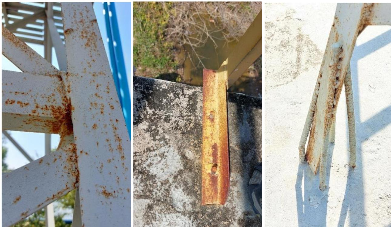
**Figure 34 : Traces de corrosion sur la structure métallique du château d'eau**
