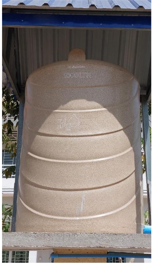
**Figure 35 : Systèmes de protection des rayons solaires des cuves de stockage d'eau traitée**
