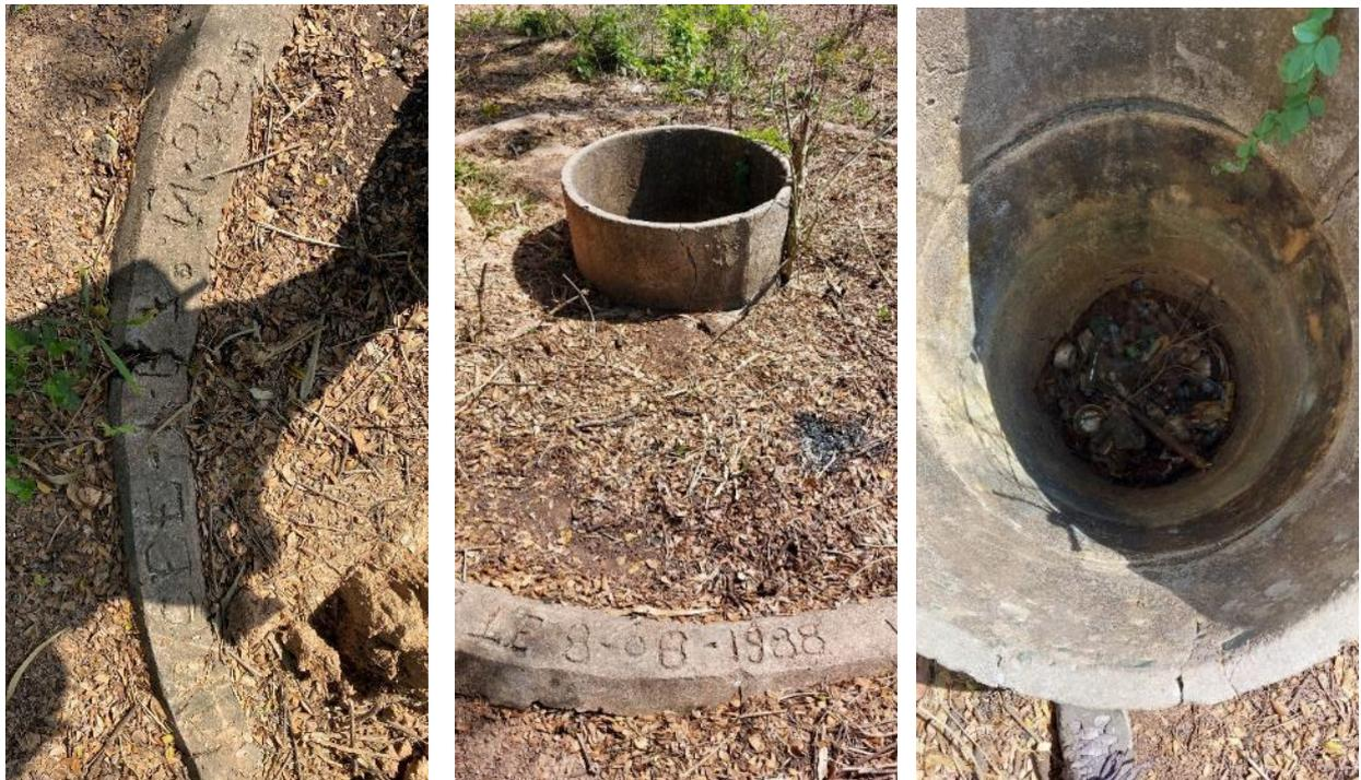
Figure 7 : Puits UNICEF de 1988 abandonné
