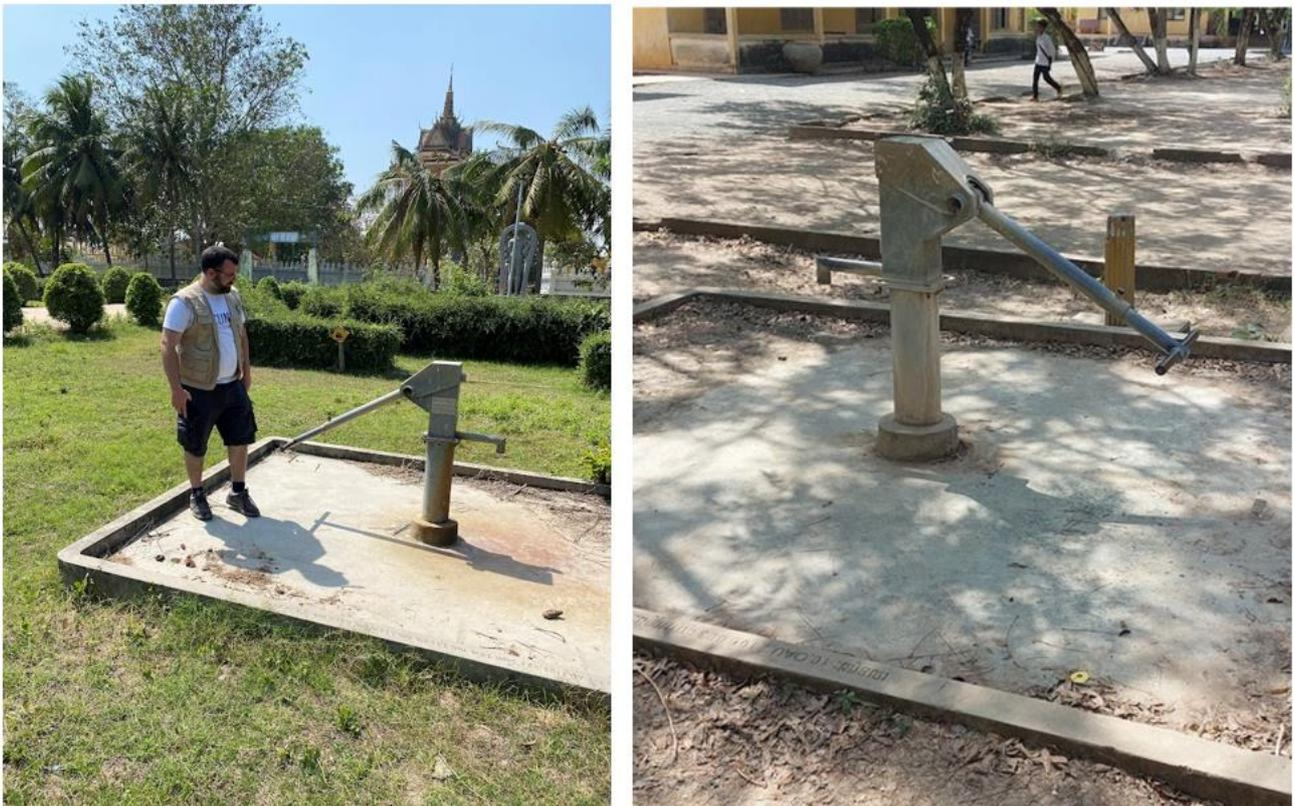
Figure 22 : Forages Oxfam équipés de PMH à l'école primaire (gauche) et au lycée (droite) de Prey Lvea.
