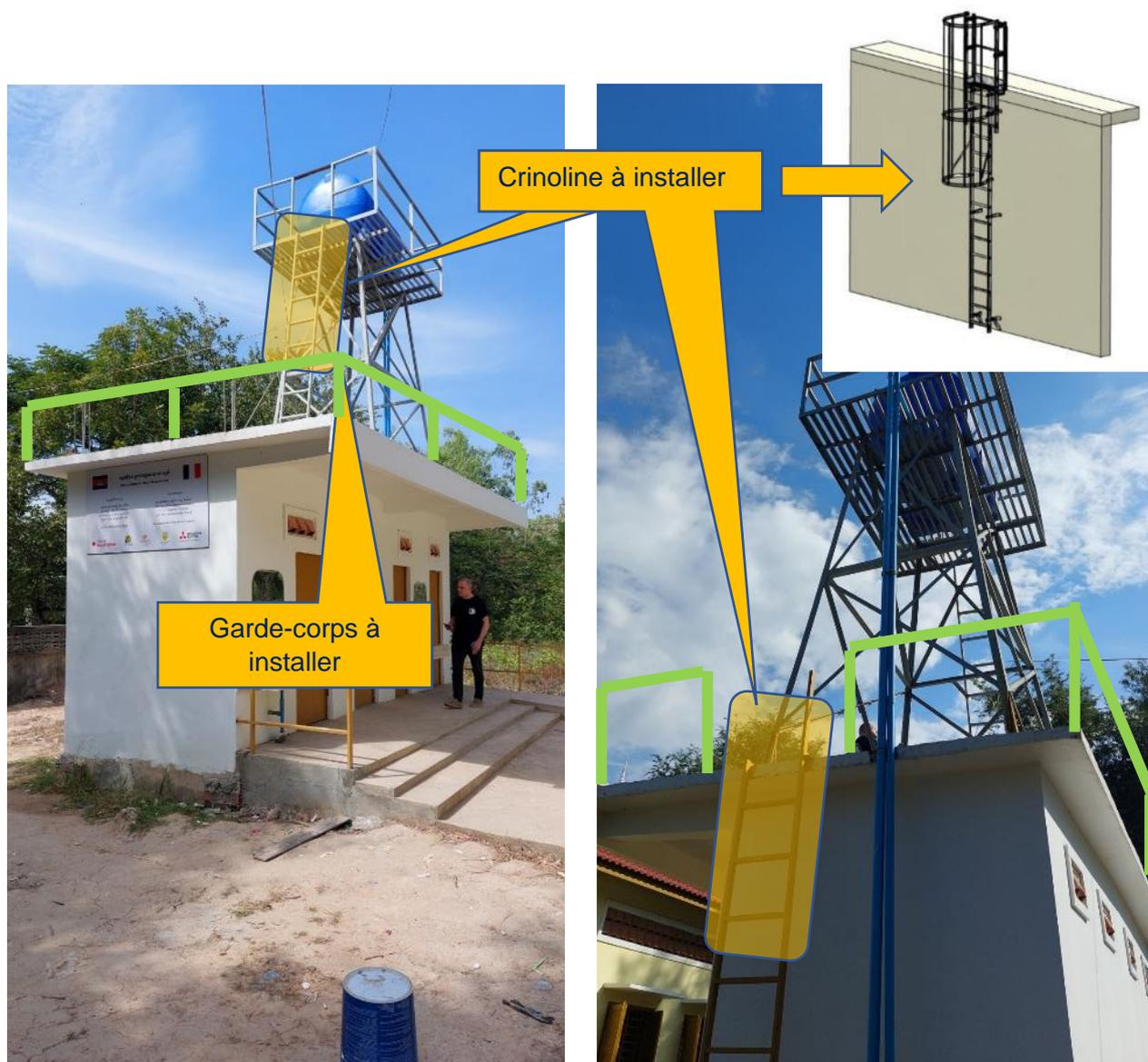
Figure 33 : Propositions de travaux de mise en sécurité du « château d'eau »
